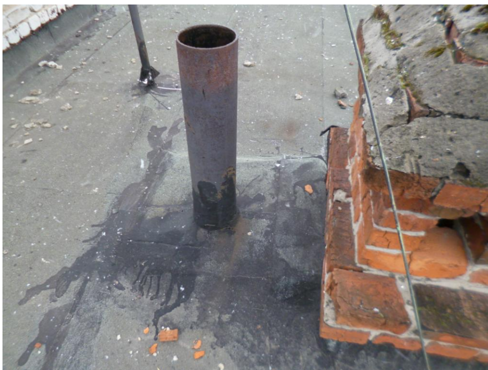
Фото 6. Коррозия металла фановых труб.
