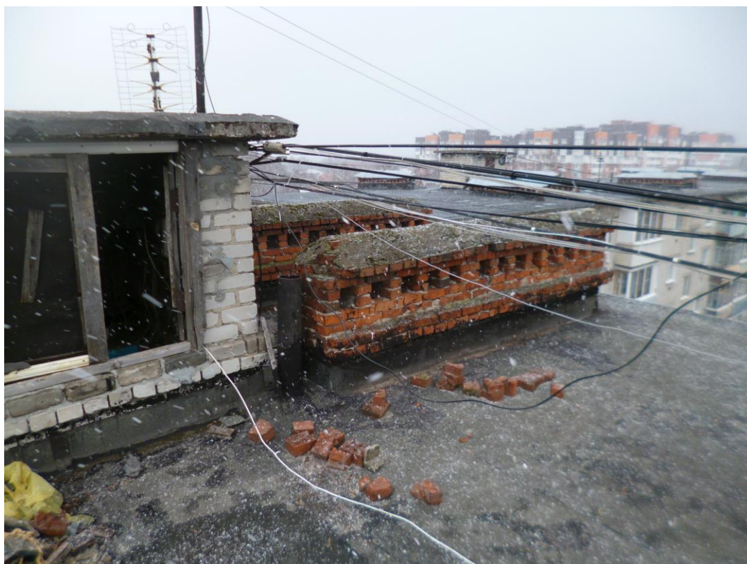
Фото 5. Отсутствие двери в будке выхода на кровлю.
