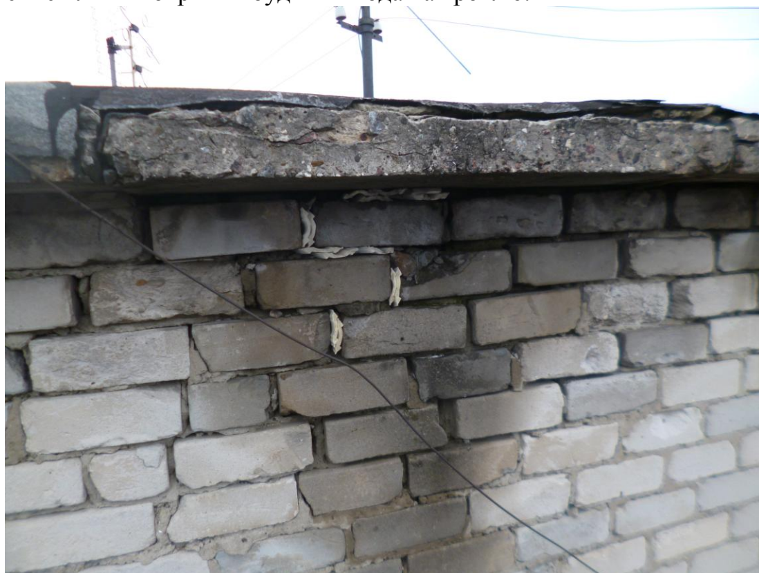
Фото 4. Разрушение швов кирпичной кладки в будке выхода на кровлю. Разрушение плиты покрытия будки выхода на кровлю.
