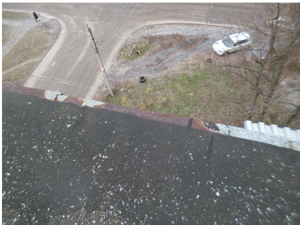
Фото 3. Коррозия отливов карнизов крыши
