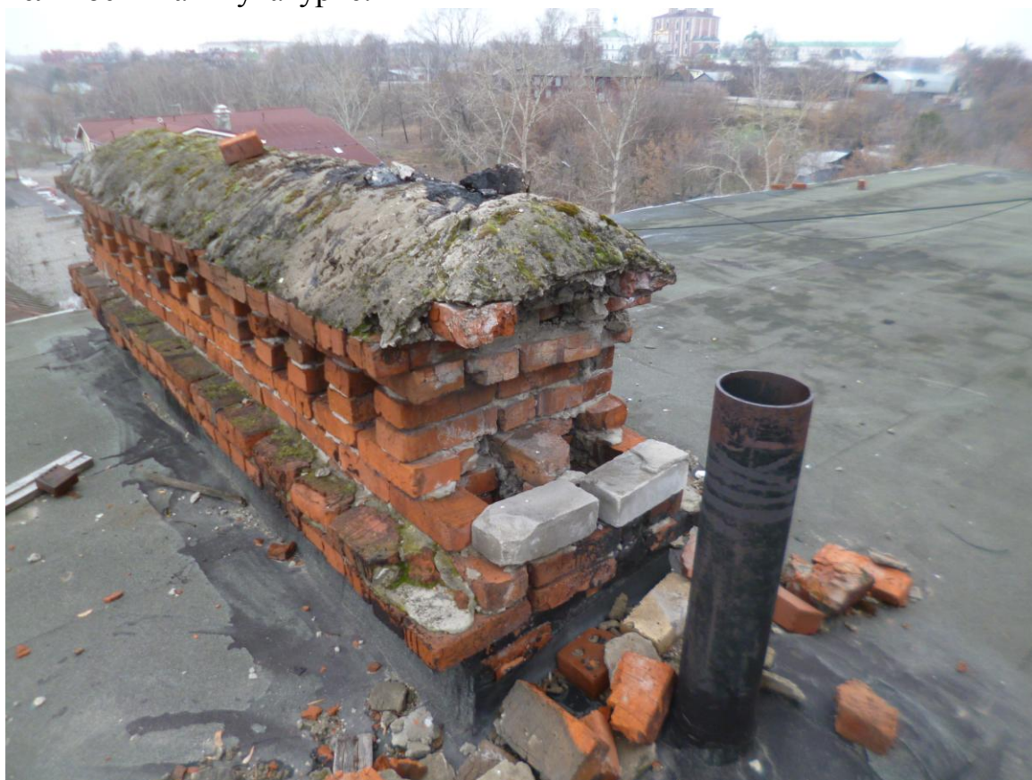
Фото2. Вентканалы, разрушение кирпичной кладки, разрушение штукатурки, растительность на штукатурке.
